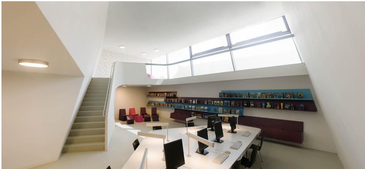
Treppenanlage mit anschließender gebogener Brüstungsverglasung aus VSG aus 2x12mm ESG (Kat. B)
